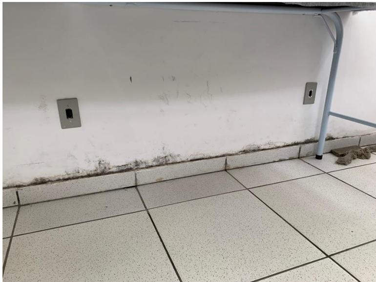
Figura 9 – Rodapé a ser demolido
