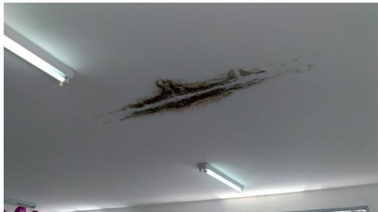
Figura 2 - Infiltrações devido ao problema do telhado
